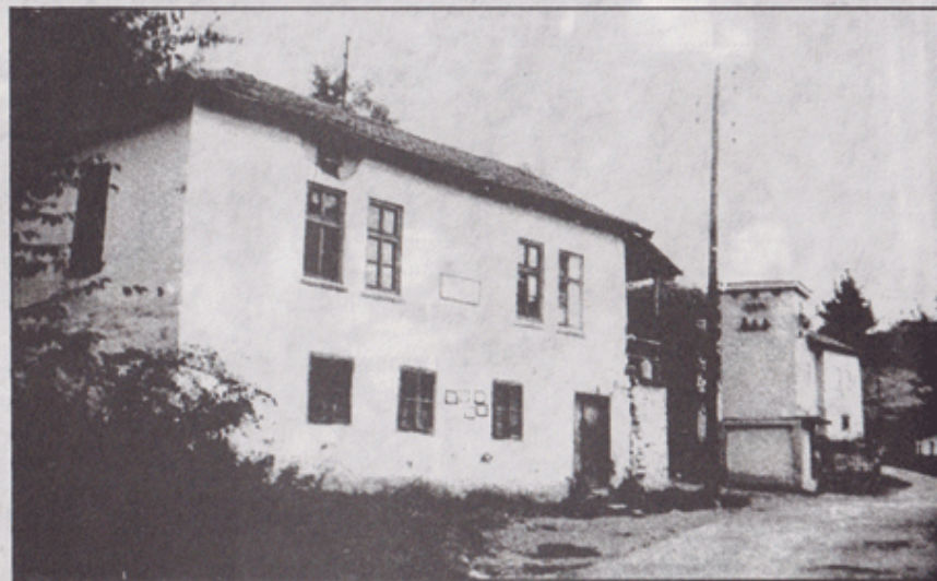
Кооперативен дом и трафопост.
