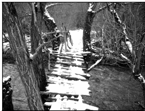
Мост при Божина огреля, Изатовци
