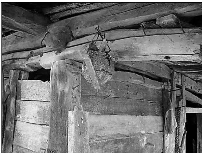
Дървената конструкция на селска къща в Изатовци
